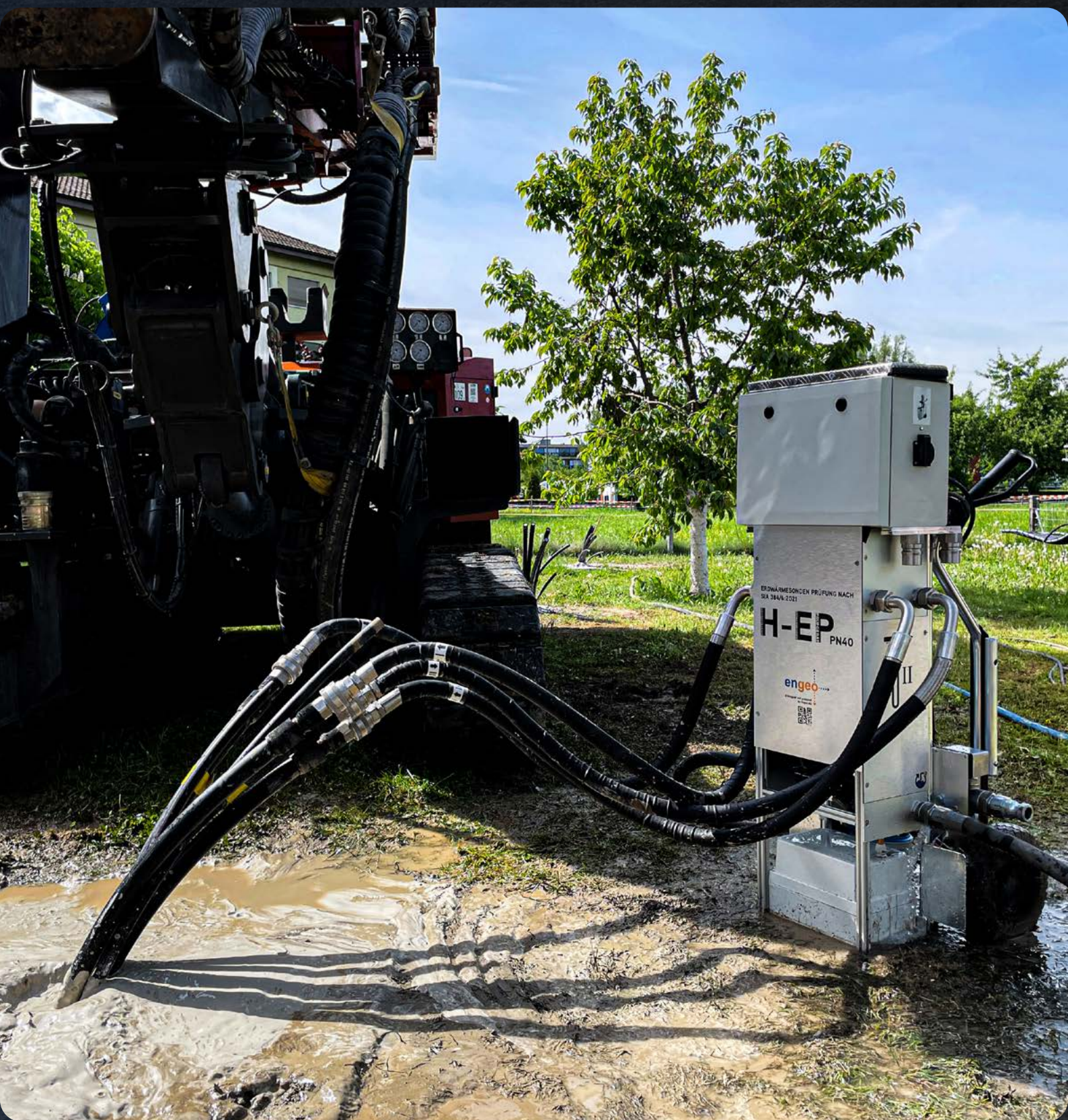
HEP lors du contrôle des sondes géothermiques
